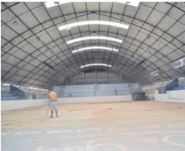
Ginásio está recebendo a colocação de piso emborrachado
