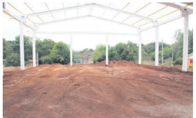
Ajuste em terraplanagem de empresa também foi realizado
