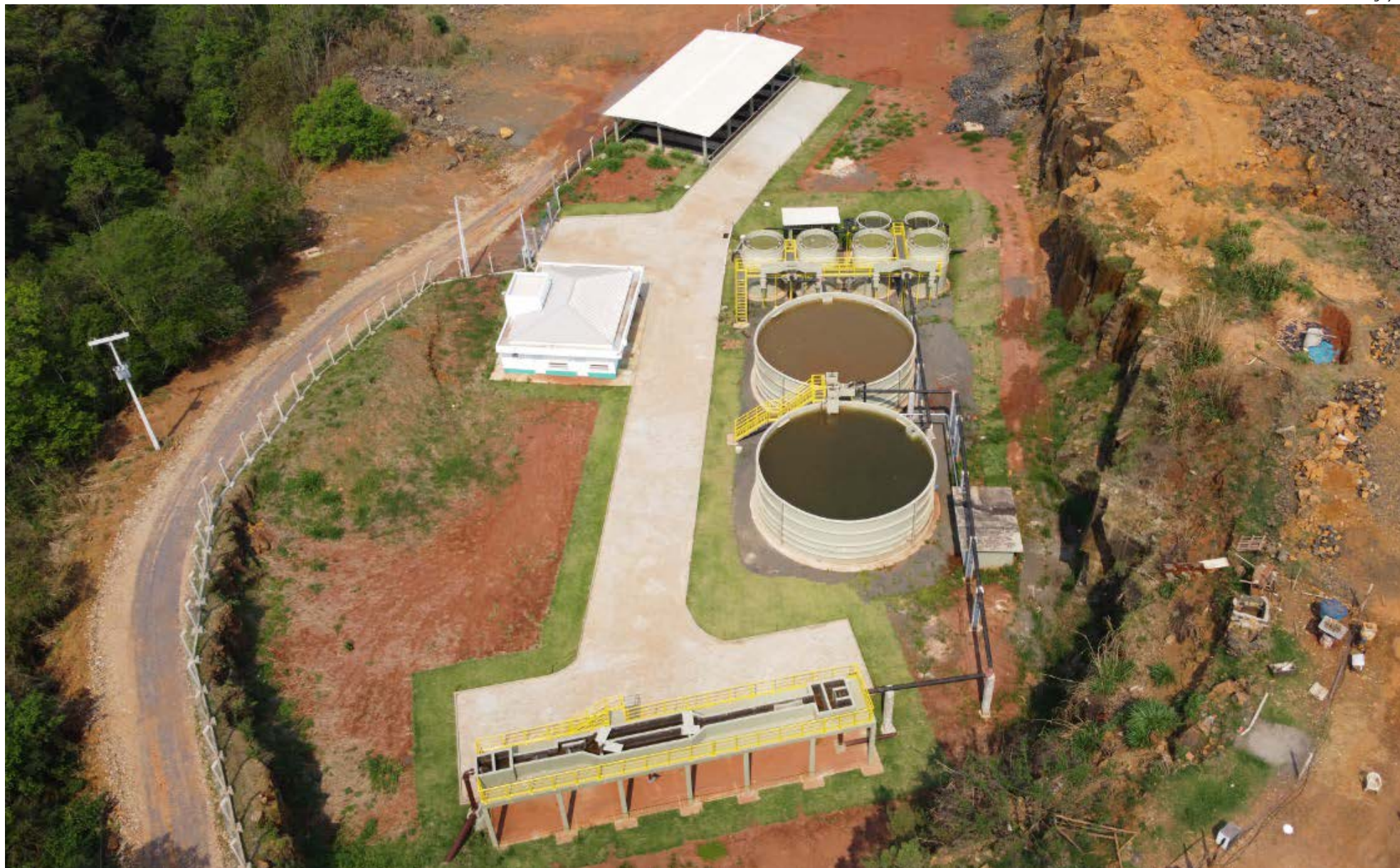
Estação entrou em funcionamento em novembro do ano passado
