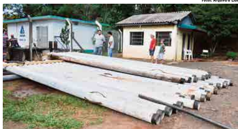
Tubulações do poço profundo estavam corroídas, sendo necessário fazer a revitalização das mesmas
