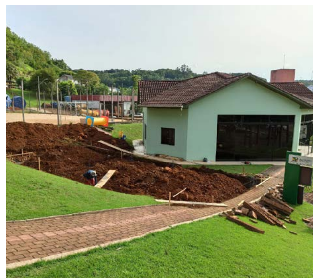
Nova sala para os aparelhos de ginástica e para fisioterapia estão sendo construídas
