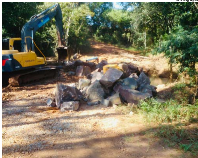
Trabalhos foram realizados na ponte da Linha Jundiá
