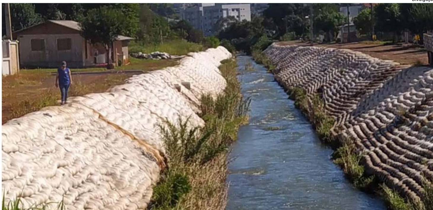
Vistoria apontou que não há focos do mosquito no leito do rio
