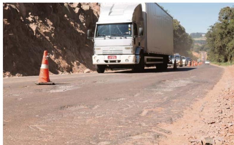
Asfalto já está deteriorado após início das obras
