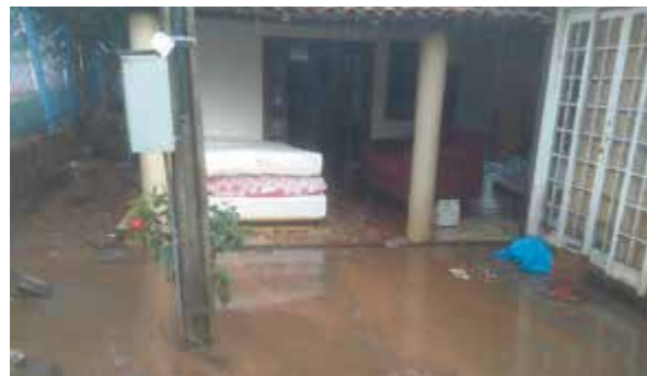
Alagamento em residência no Bairro Pioneiro
