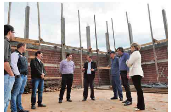
Moratelli esteve na obra do novo quartel do Corpo de Bombeiros
