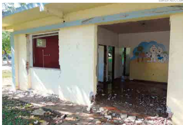
Estrutura será retirada para construção do Centro de Saúde
