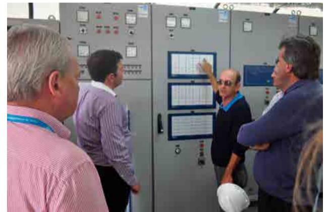
Moratelli visitou subestação da Celesc na tarde de quarta-feira (24)
