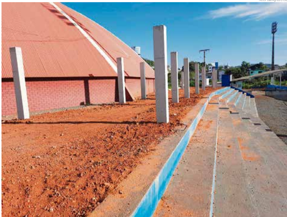
Construção está na fase de cura dos pilares
