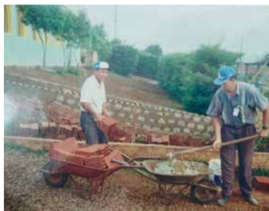
Etapa de construção
