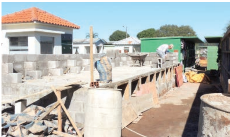
Novas gavetas estão sendo construídas no Cemitério Municipal São Miguel e Almas
