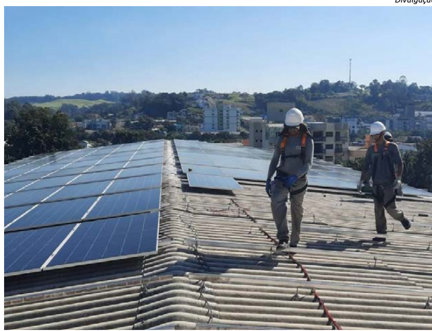
Trabalho de instalação das placas de energia solar
