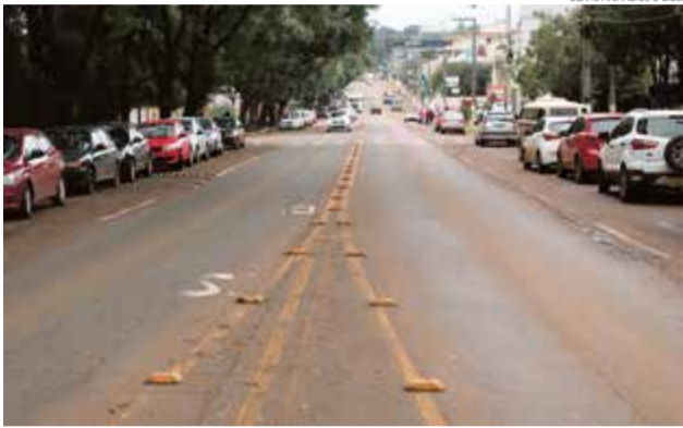
Obra será no trecho entre o trevo a esquina com a Avenida Sul Brasil
