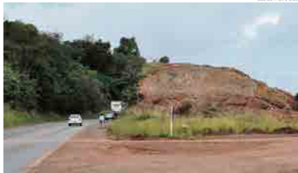
Rocha será detonada para instalação de uma via lateral
