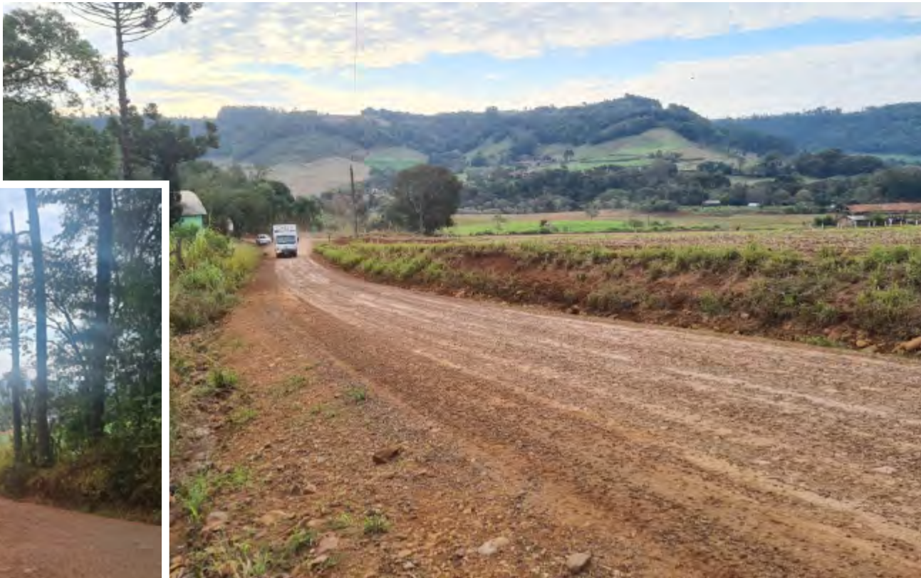
Trecho na Linha Consoladora, próximo da sede comunitária
