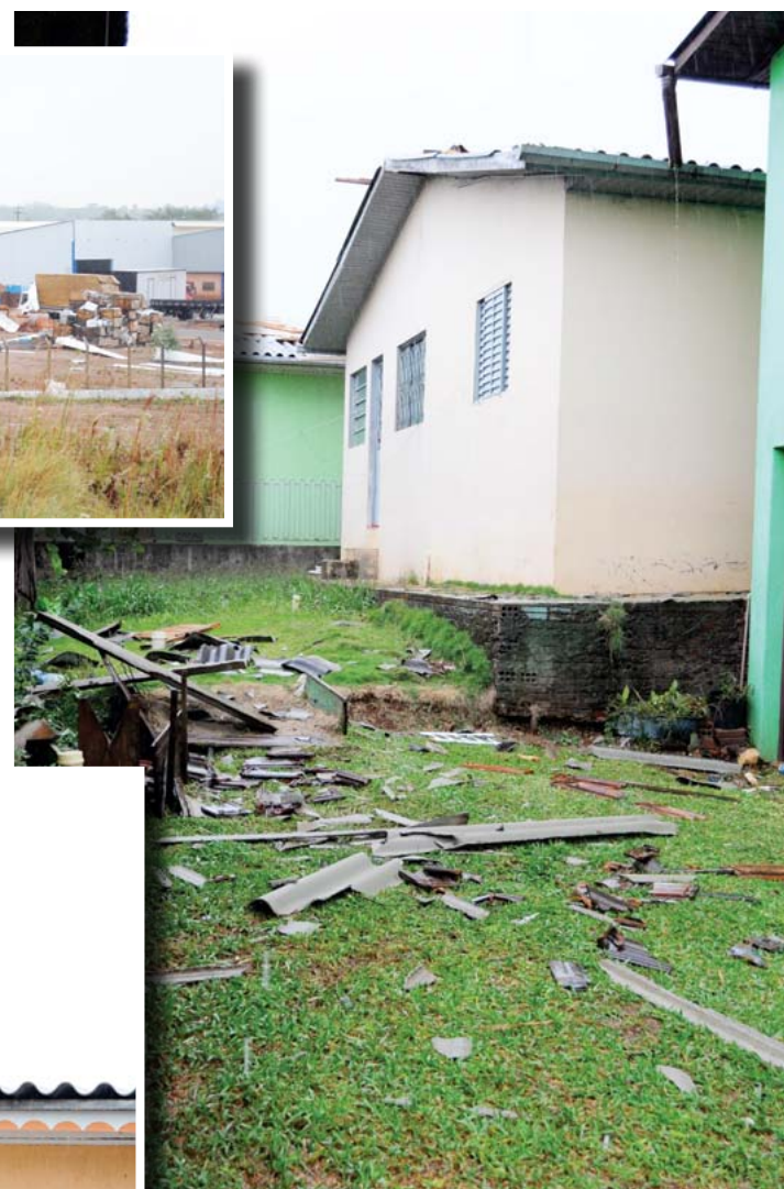
Destroços de casas foram lançadas para terrenos vizinhos
