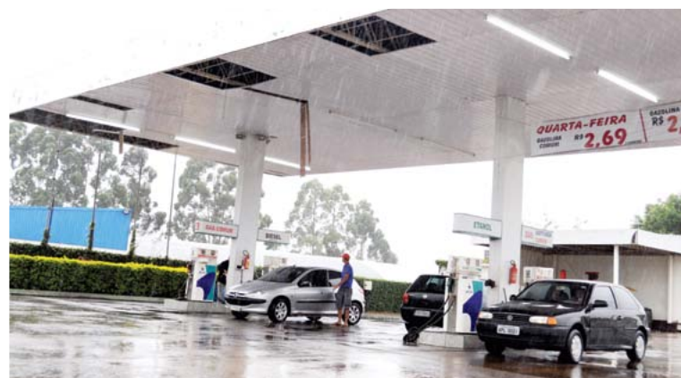
Posto Delta teve parte do forro danificado
