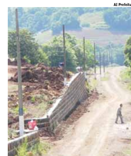
No total serão investidos R$ 359 mil para a conclusão das obras
