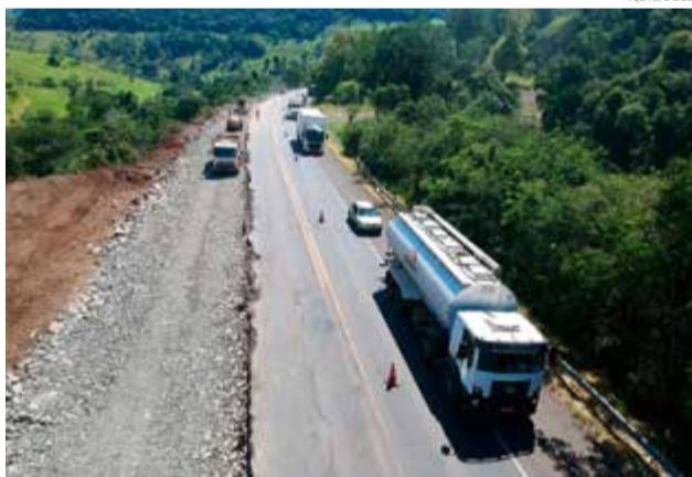
Serviço de implantação de terceiras faixas na região de São Miguel do Oeste
