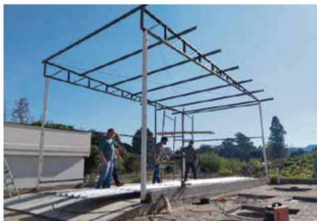
Estrutura metálica e cobertura fica na parte dos fundos da sede no Bairro Universitário
