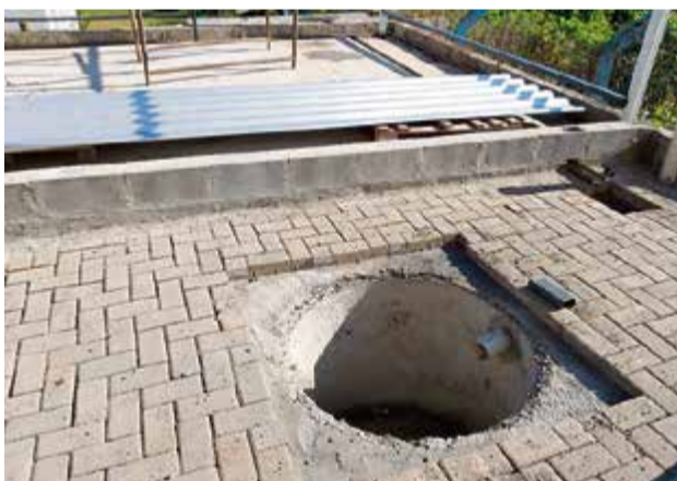
Compartimento no piso será para tratar água em razão de produtos químicos
