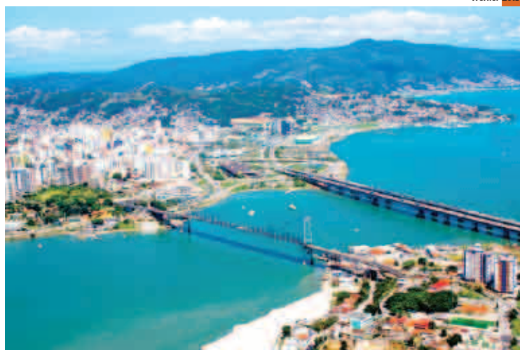
Ponte Hercílio Luz, Colombo Salles e Pedro Ivo Campo, entre a ilha
