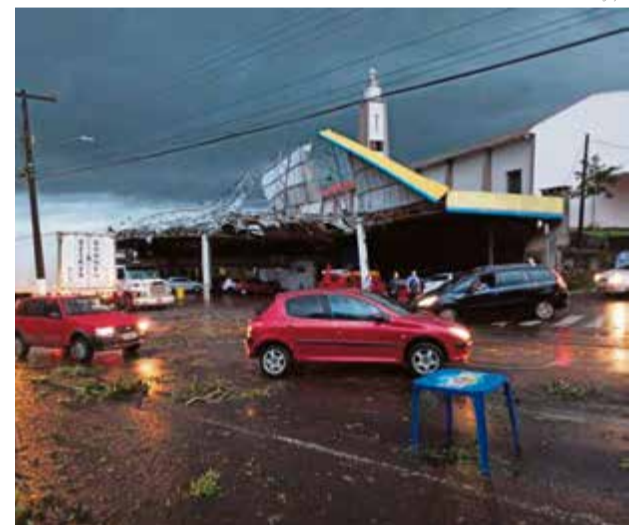
Registro da cobertura de um posto de combustíveis em Descanso
