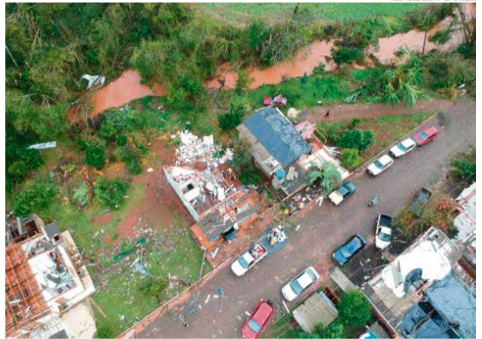
Estima-se que os ventos tenham se aproximado dos 130 km/h
