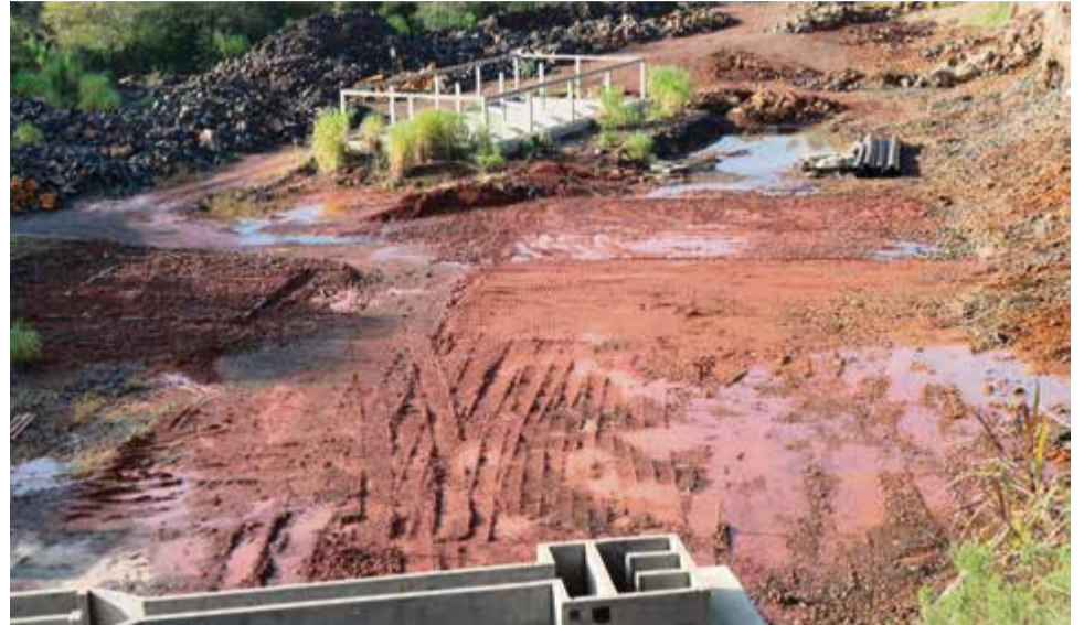
Retomada das obras contou com terraplanagem para construção dos reservatórios
