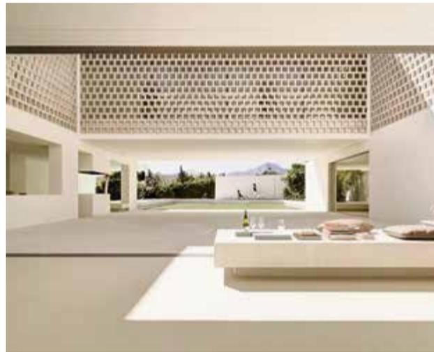
Aproveitar a luz e a ventilação sem abrir mão da privacidade e muito menos de um charme arquitetônico. Essas são as principais funções dos cobogós, elementos vazados, originalmente feitos de cimento e tijolos.
