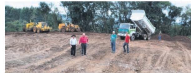
Terraplanagem na Linha Nova foi realizada nesta semana
