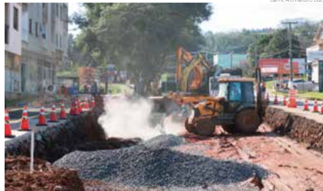
Obra começou nas proximidades do trevo
