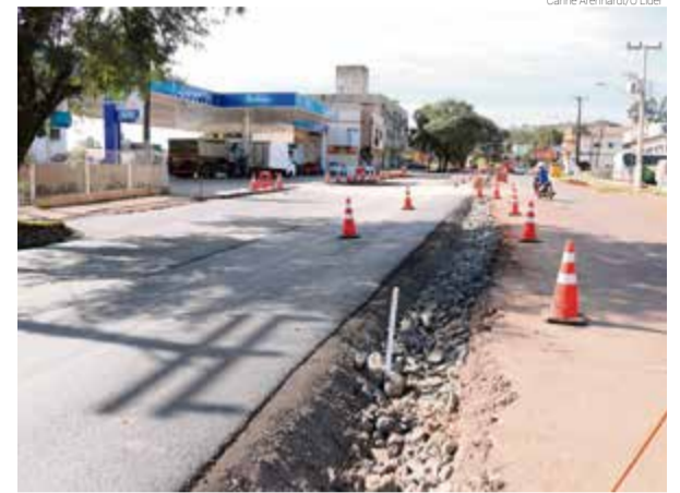
Primeira camada de asfalto foi colocada nesta semana
