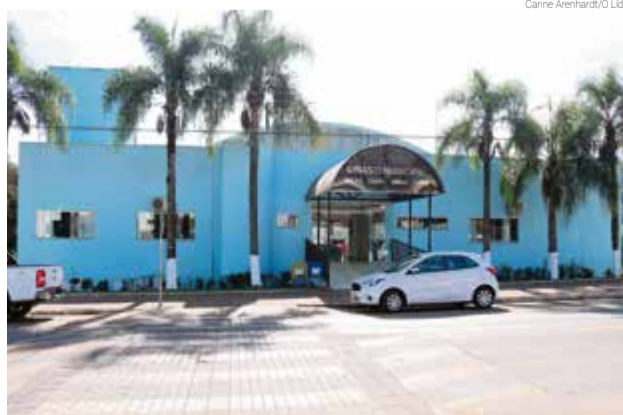
Manta vai prevenir goteiras e melhorar sensação térmica
