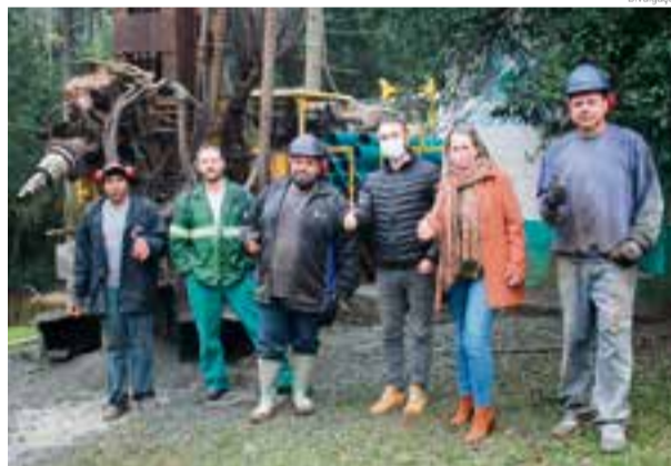
Equipe trabalhou na perfuração do poço nesta semana
