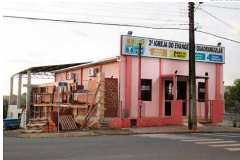
Obra de ampliação está em andamento
