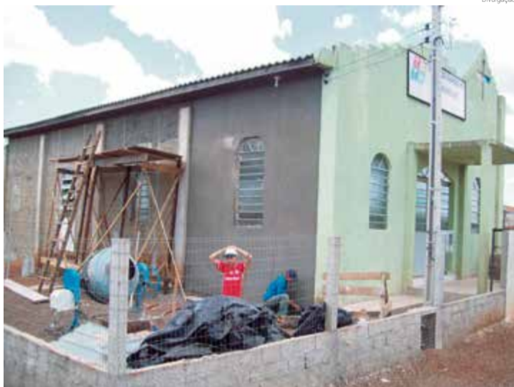
Estrutura da igreja em 2011
