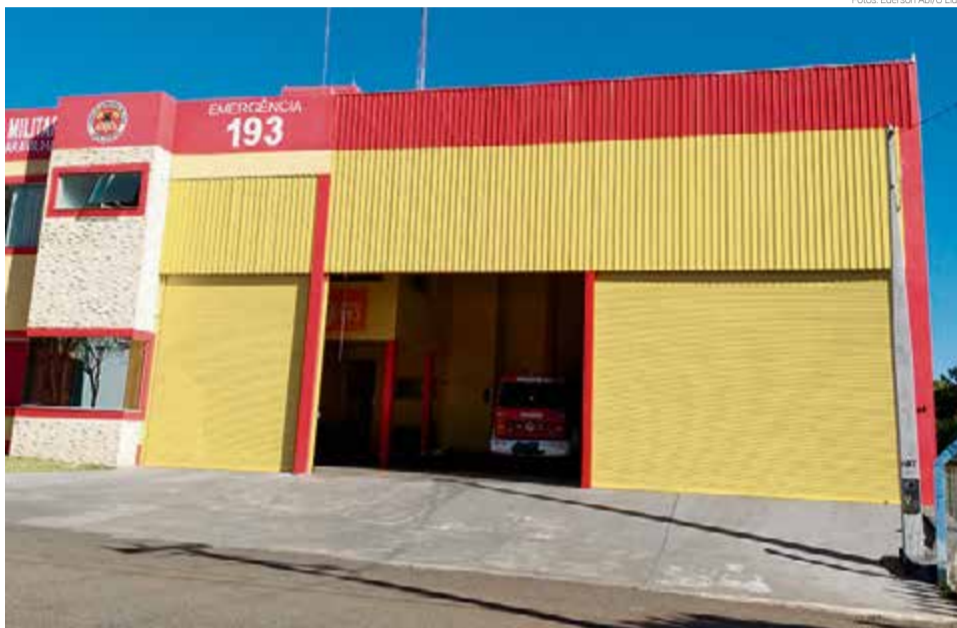
Frente foi fechada com porta de rolagem para proteger viaturas
