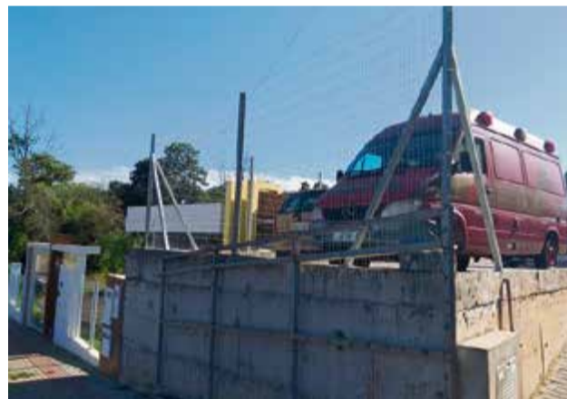
Sede foi cercada para garantir segurança e Habite-se da estrutura
