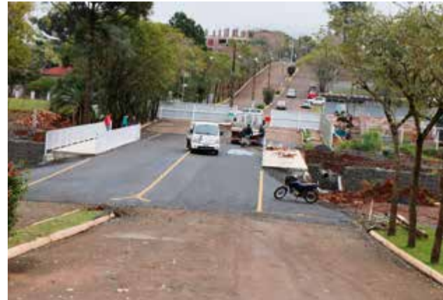
Registro feito na sexta-feira (26) mostra a nova estrutura
