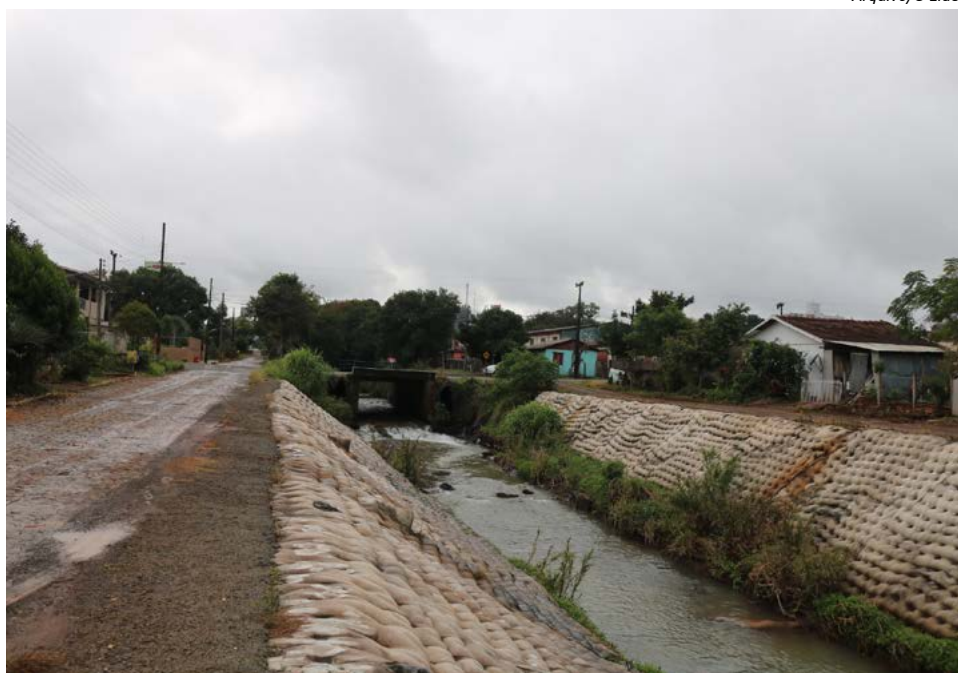
Obra no rio reinicia no trecho próximo a Rua Doutor Leal Filho
