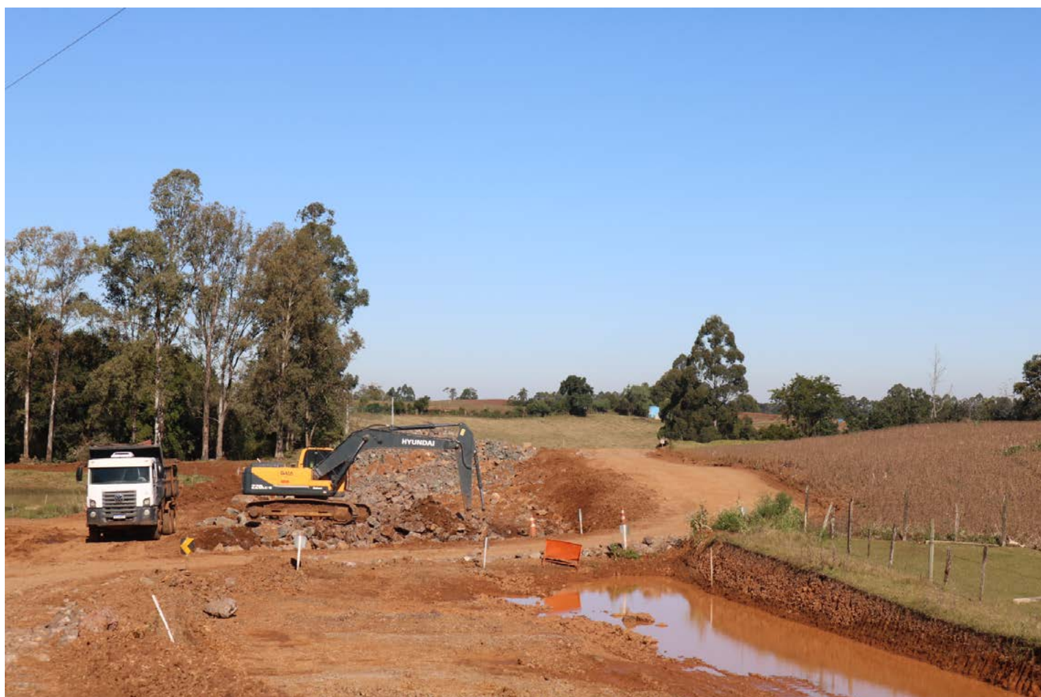
Trabalho de detonação de rochas e escavação, próximo a cidade
