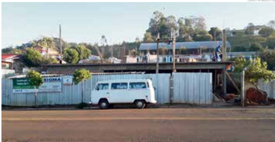
Construção está no segundo piso e a previsão para a conclusão dos trabalhos é dezembro
