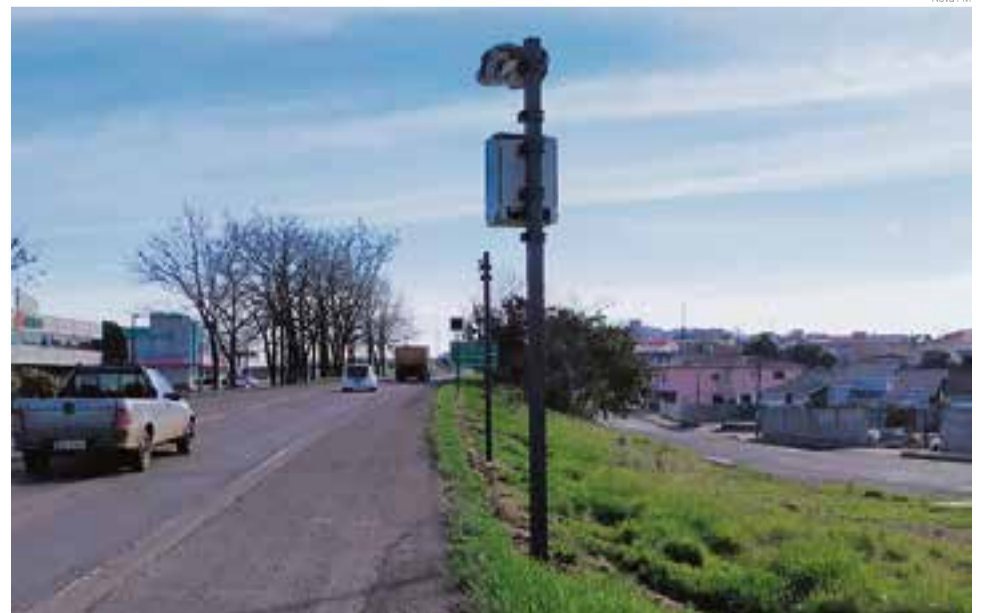
Equipamento instalado em Pinhalzinho
