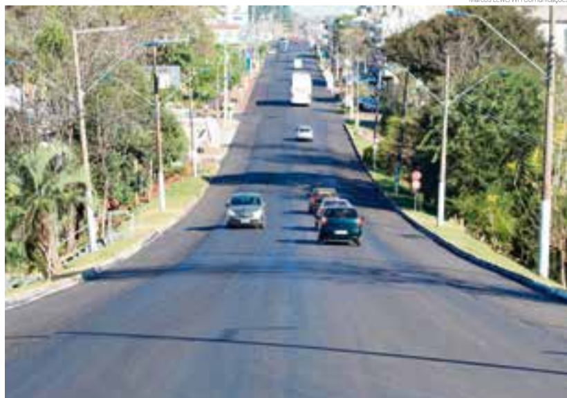
Gaia Rodovias atua com frente de trabalho na Avenida Waldemar Rangrab, em São Miguel do Oeste
