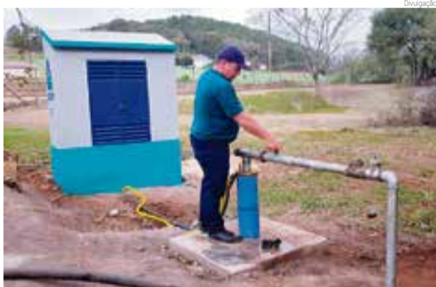
Trabalhos foram finalizados e a população não sofrerá mais com a falta de água
