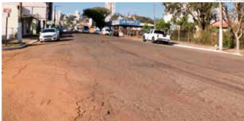
Avenida Anita Garibaldi terá restauração do pavimento
