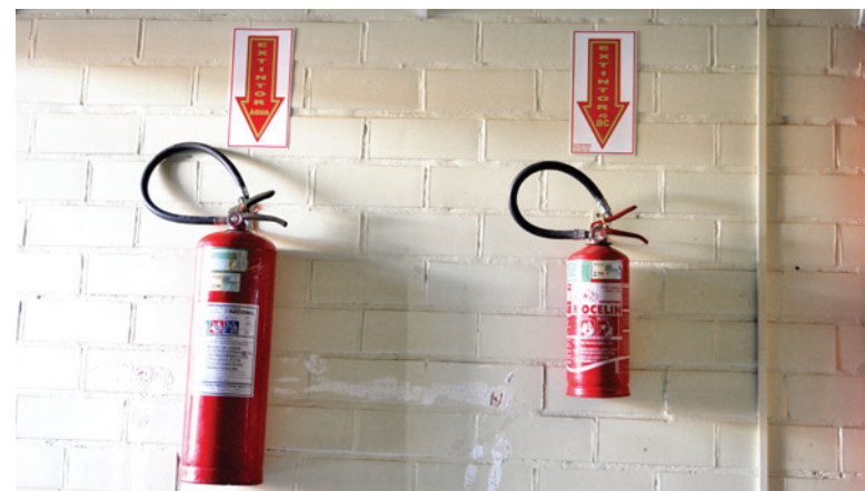
Sistema preventivo de emergência, como extintores e iluminação, foi trocado
