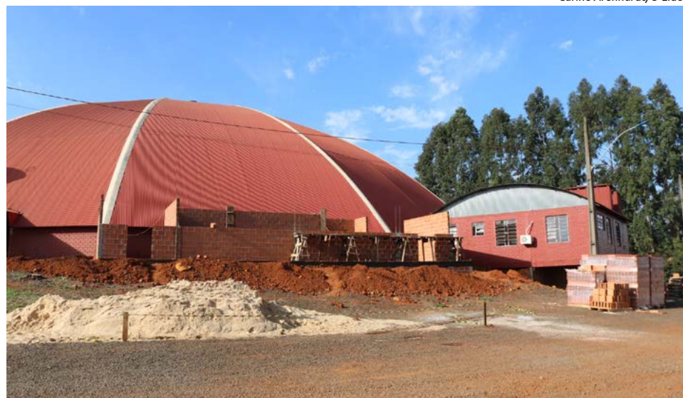
Parque já começa a receber obras para a feira
