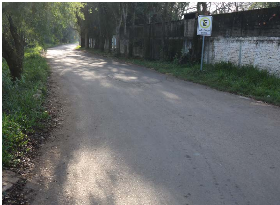
Obra na Avenida 27 de Julho inicia na esquina com a Araucária
