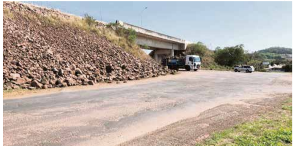
Trabalho deve começar na região de São José do Cedro, com reconstrução do elevado e obras acessórias
