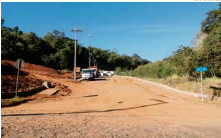
Reperfilamento asfáltico será feito na Rua Alemanha no acesso ao Loteamento Nosso Sonho
