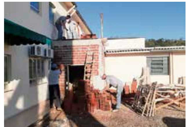
Equipe atua na construção da estrutura para instalação do segundo elevador
