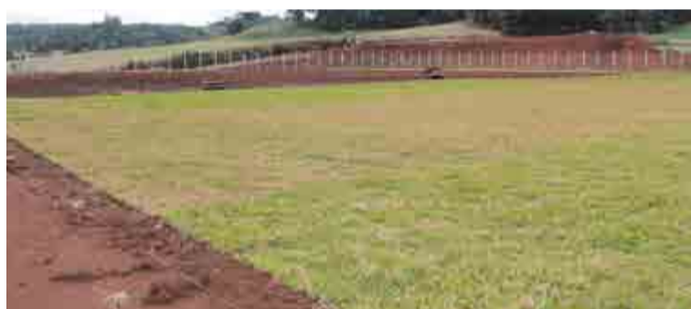
Campo Municipal é outra obra em destaque que está sendo concretizada no município
