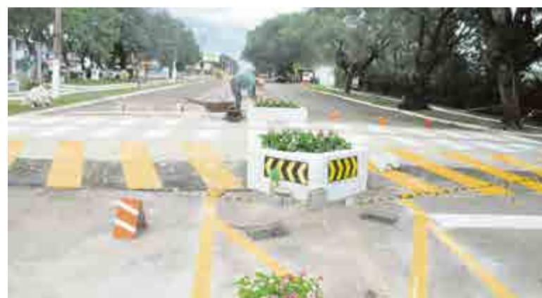
Faixa elevada em frente ao Caic já foi instalada
