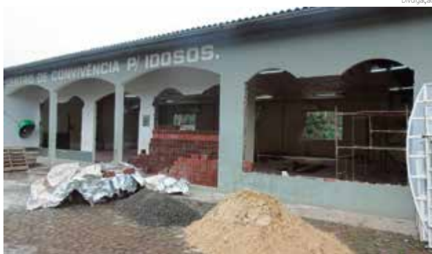
Estrutura está recebendo diversas melhorias
