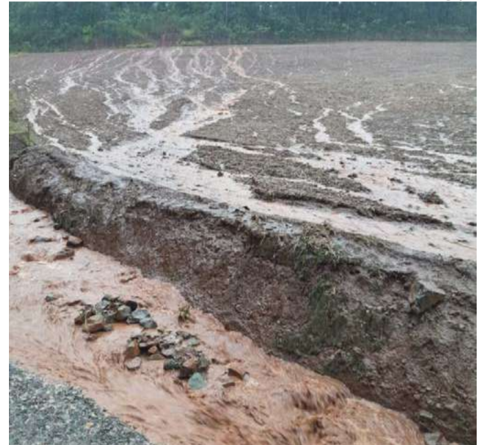
Chuva danificou estradas e plantações
