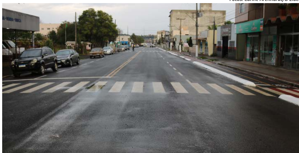
Pintura e sinalização das pistas e estacionamentos concluída
