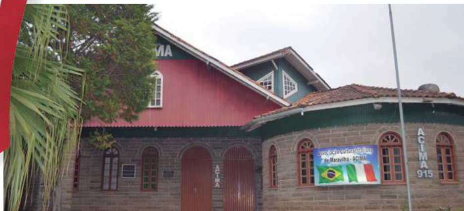
Estrutura fica localizada na Avenida Araucária
