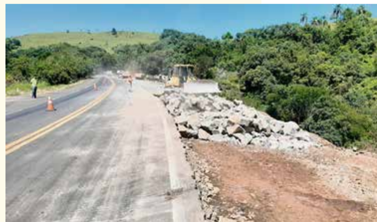
Obras de restauração e adequação de capacidade estão em andamento
