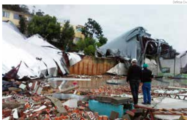
Registro mostra galpão destruído em Palmitos
