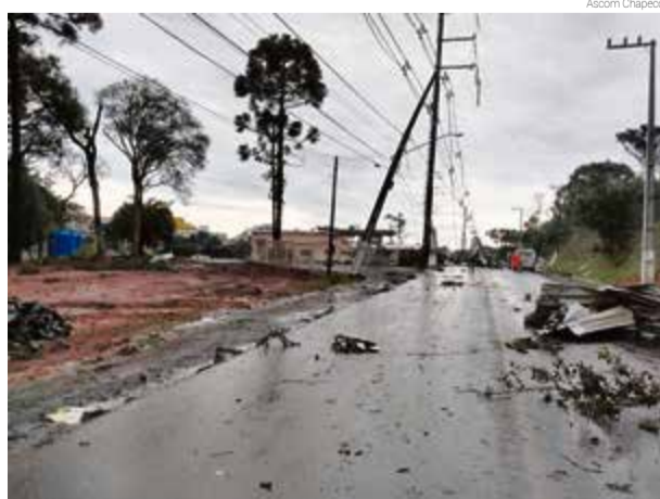
Postes e redes elétricas foram danificados, causando queda de energia
