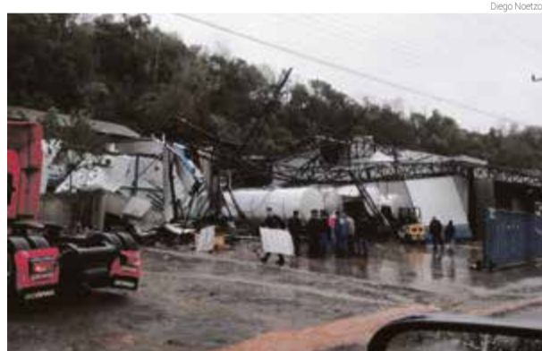
Barracão que abrigava tanques de caminhões foi danificado
