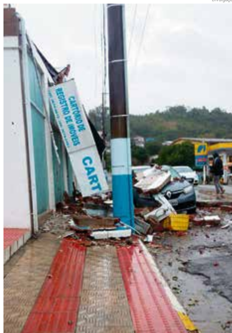
Foto mostra veículo atingido por pedaço de construção
