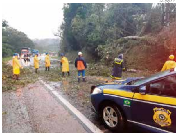
Policia Rodoviária e bombeiros atuaram na desobstrução da rodovia
