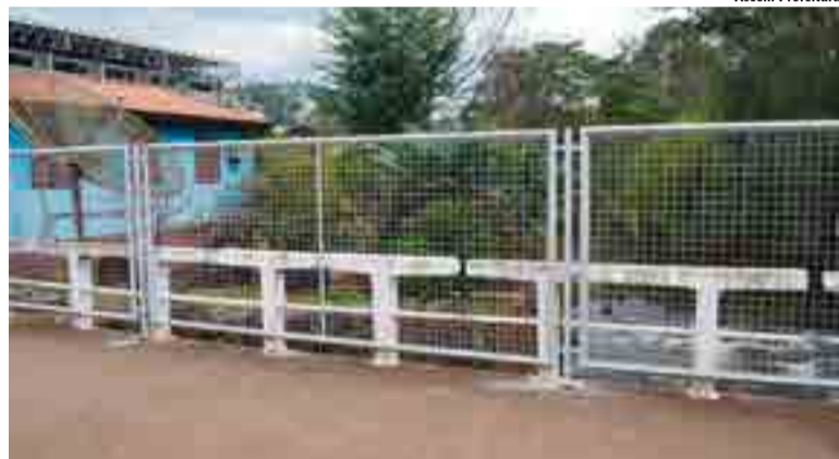
Cerca de segurança visa a proteção e a segurança das pessoas que ali passam
