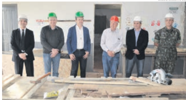
Curso trabalha com a prática nas reformas do prédio onde funcionará o Casep
