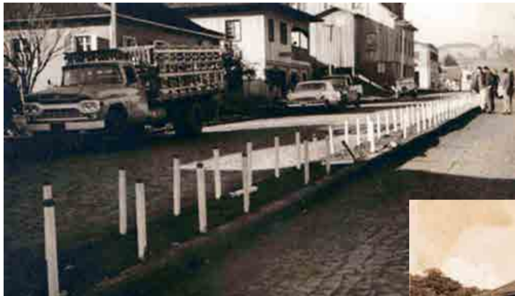
Primeiro calçamento sendo construído na cidade
