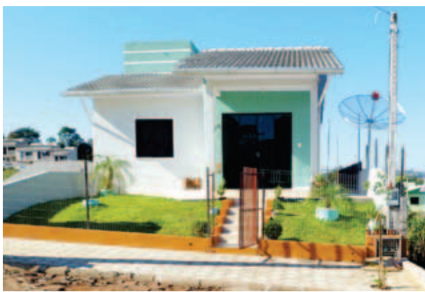
Casa de alvenaria com 2 pisos. Próximo a Unoesc em Maravilha.
