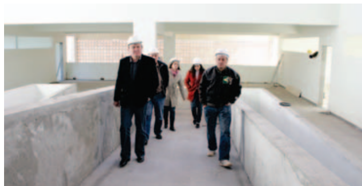
Construção da EEB João XXIII - município de Maravilha
