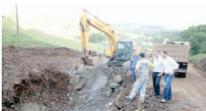
Execução de pavimentação asfáltica entre a BR-282 e o Distrito de São José do Laranjal, em Iraceminha
