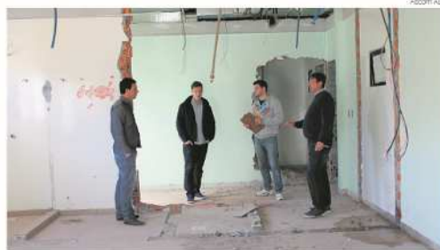
Entre as adequações e alterações no prédio estão a instalação de um elevador, reforma do piso, novo layout das salas, banheiros, parte elétrica e modernização do local
