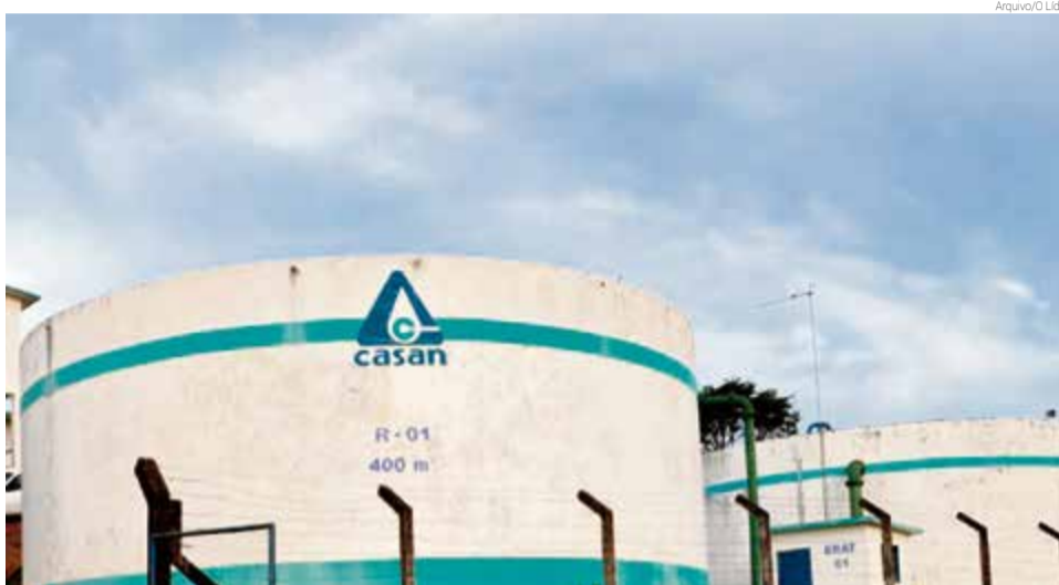
Empresa reduziu em 20% a distribuição de água por conta da troca da bomba
