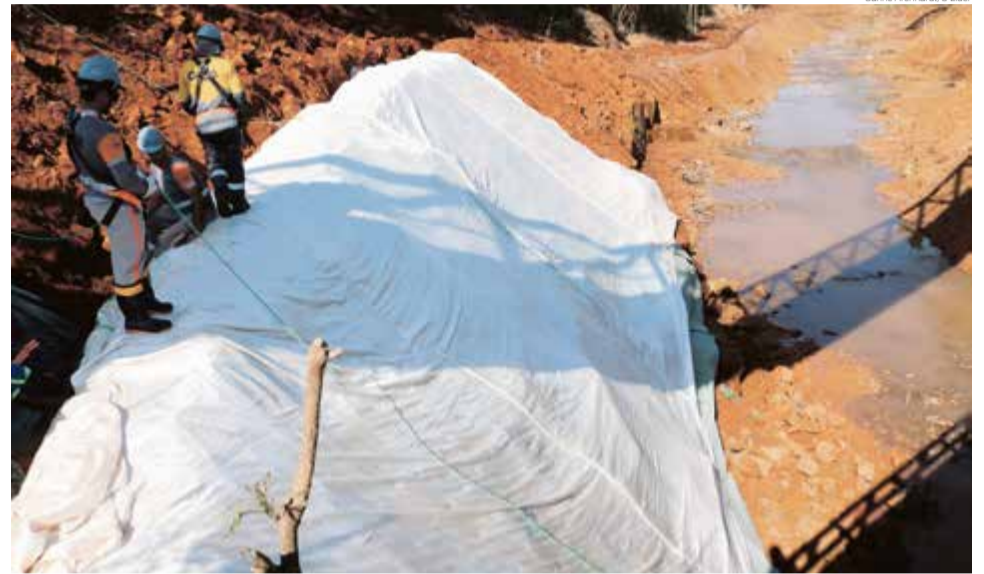
Trabalho começou no trecho próximo à BR-282
