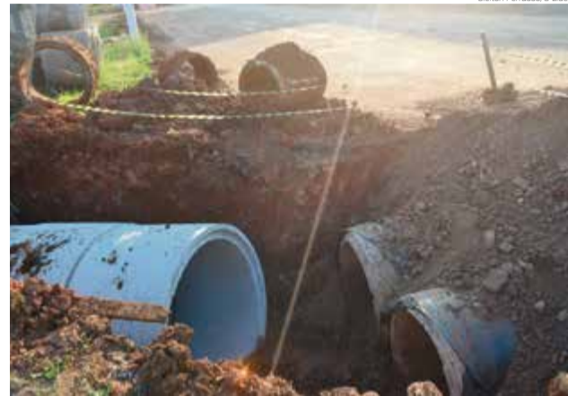
Cerca de 70 tubos serão trocados na Avenida Sul Brasil
