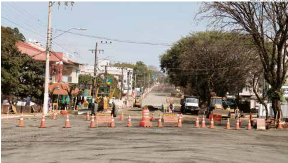
Trecho final está pronto para receber o asfalto
