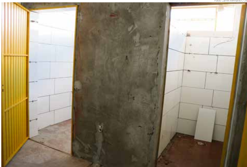
Paredes estão inacabadas
