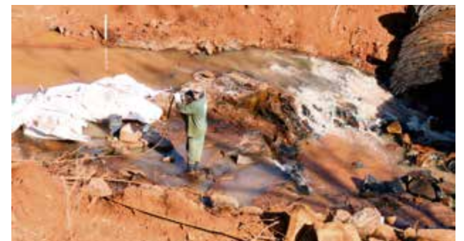
Equipe faz perfurações na laje onde são colocados os explosivos
