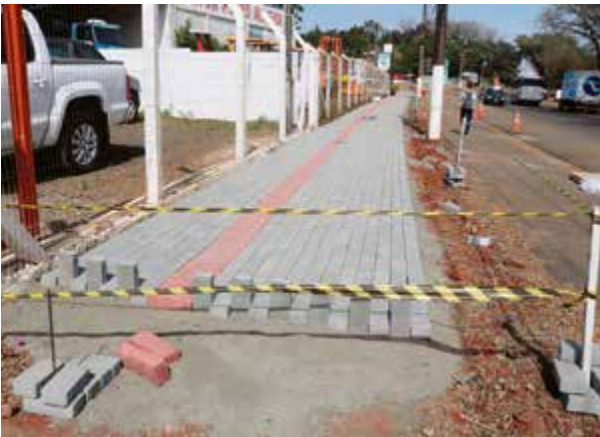
Trabalho de construção dos passeios públicos
