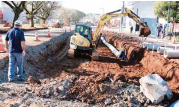
Escavações para preparo da base foram encerradas nesta semana
