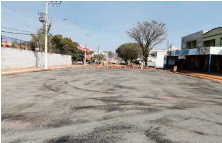
Trecho final da Avenida será asfaltado
