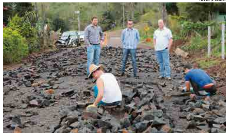
Prefeito, engenheiro e vice-prefeito vistoriaram as obras
