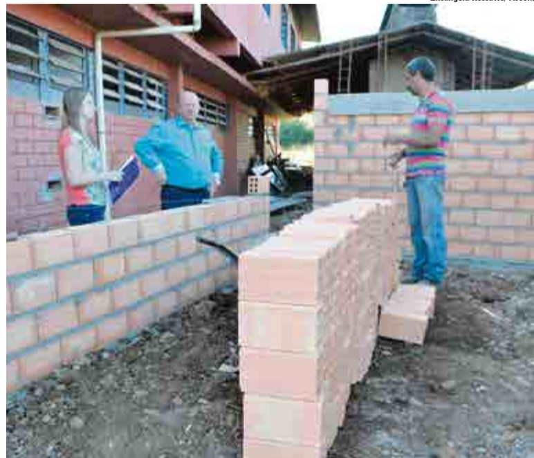
Prefeito acompanhou as obras de construção da churrasqueira, sanitários e da sala de carnes
