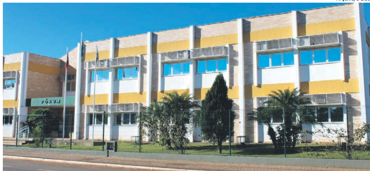
Trabalho é realizado no Fórum de Maravilha
