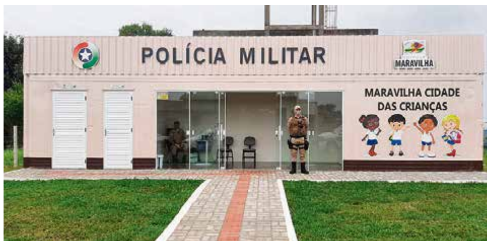
Base está instalada na Rua Pastor Armando Claas
