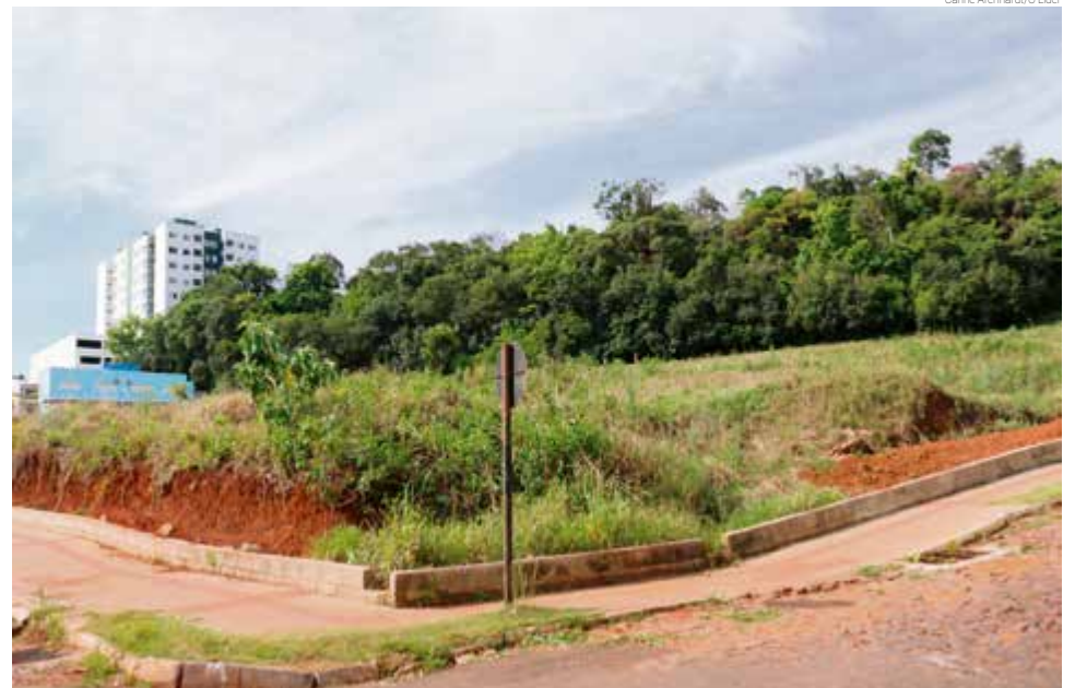
Estrutura será construída ao lado do posto de saúde
